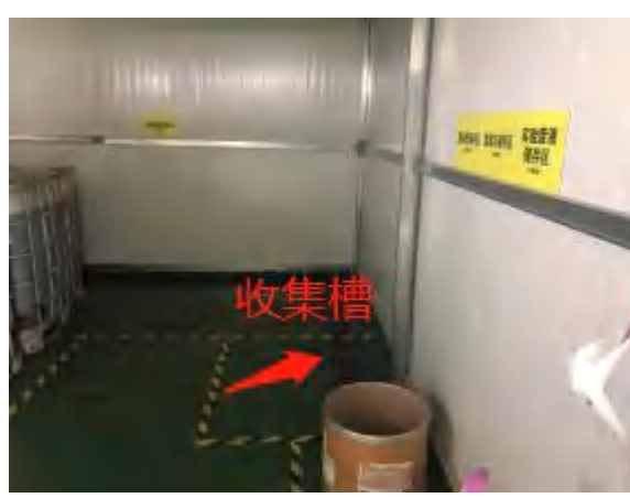
危险废物内部分类存放及收集槽
