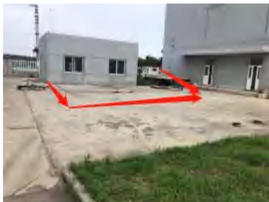
消防水池照片
