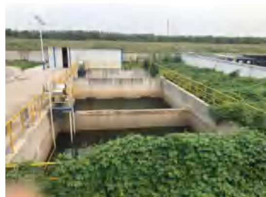
事故应急池照片
