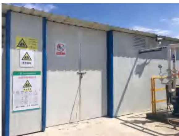
危险废物仓库全景
